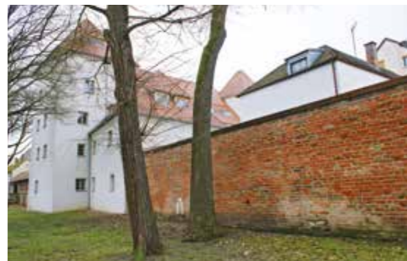
Stadtmauer an der Fronfeste, nach der Instandsetzung (2017).
