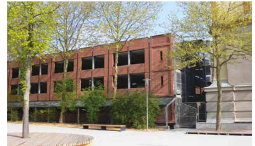
Das „Parkhaus am Wasserturm“, Fassadenausschnitt Schulhofseite nach der Generalsanierung (2015).
