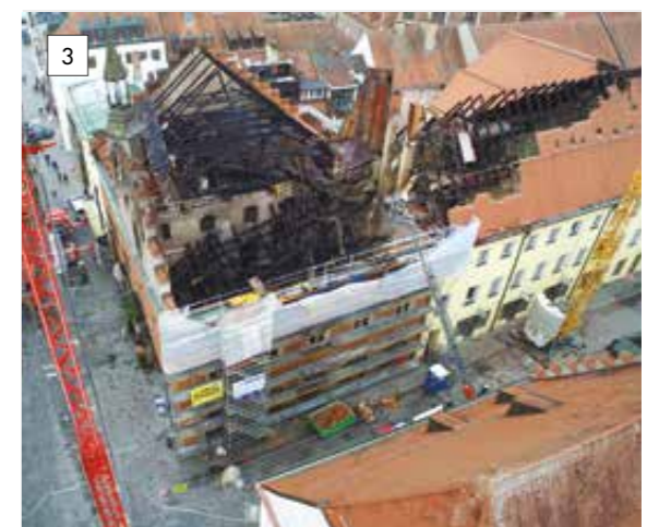
Luftaufnahme der Brandstelle (2016).
