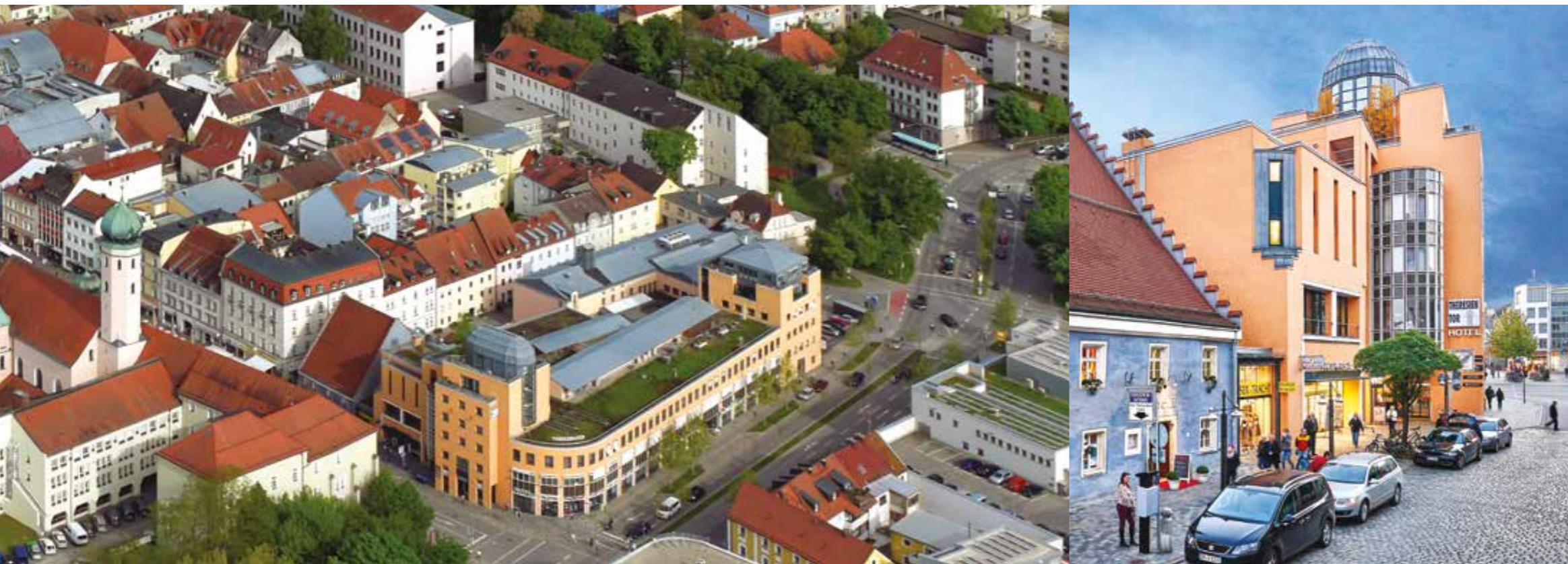
Schrägluftbild von Nordwesten: Die Blockneubauung mit dem Hotel- und Geschäftskomplex „Theresientor“ überformte die einst kleingliedrige Bebauungsstruktur. Damit entschied man sich gegen eine flächige Grünanlage in diesem Abschnitt der ehemaligen Stadtbefestigung (2015).
