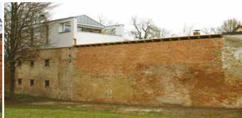
Stadtmauer am Pulverturm (Privatbesitz), nach der Instandsetzung (2017).
