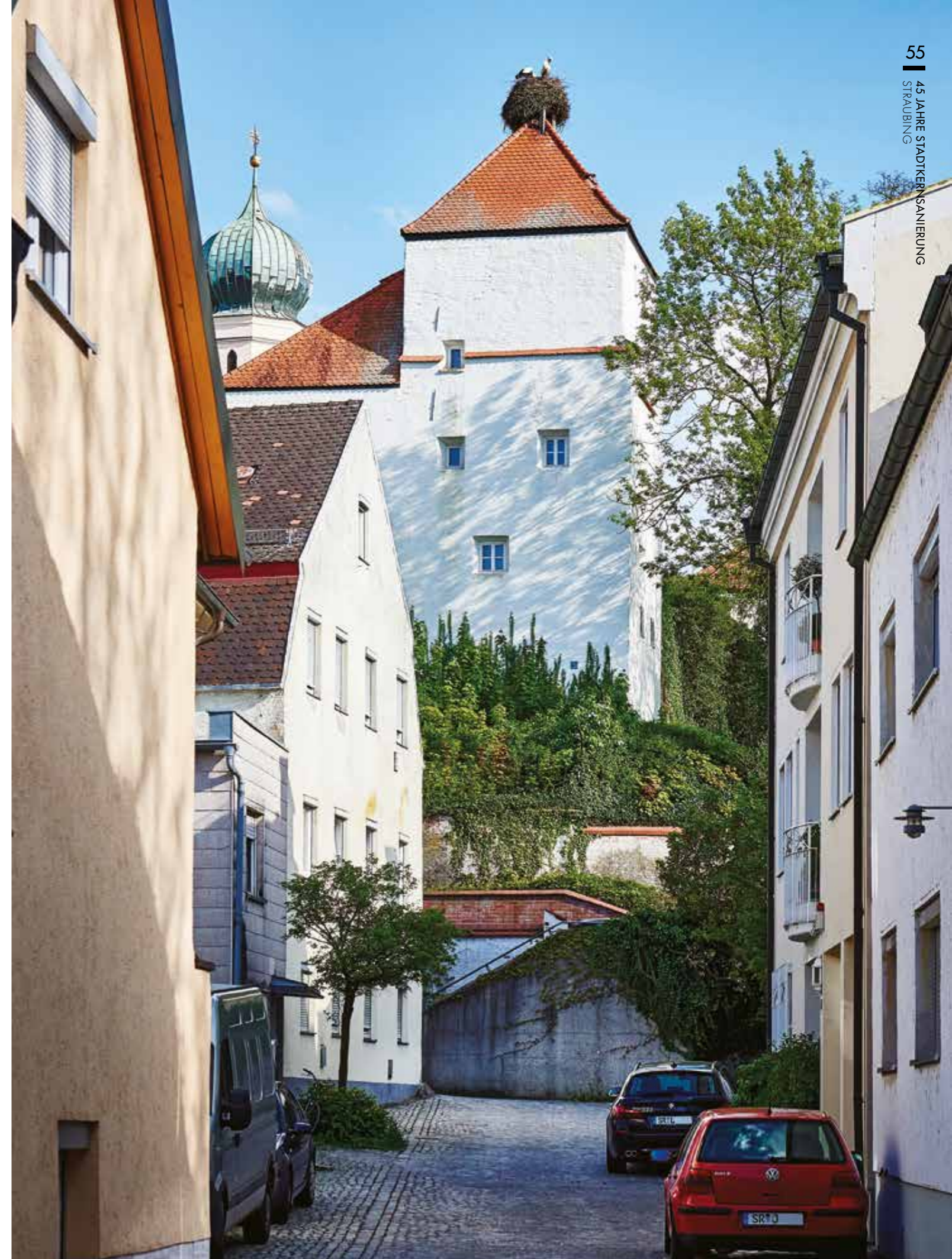
Der Weytturm, Blick aus dem Gerberviertel (2015).
