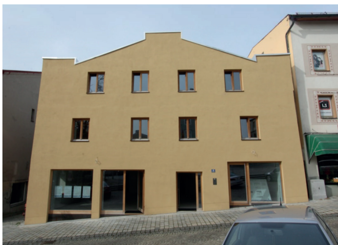
Fassade nach Sanierung mittels Fassadenprogramm
