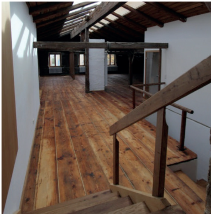
Dachgeschoss nach Sanierung, ehem. Daminger Haus Grafenau
