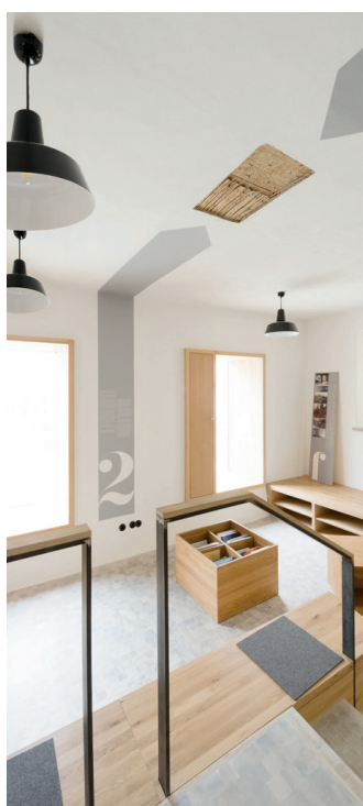
Putzträger auf Decken und Balken, Bibliothek Bauhütte
