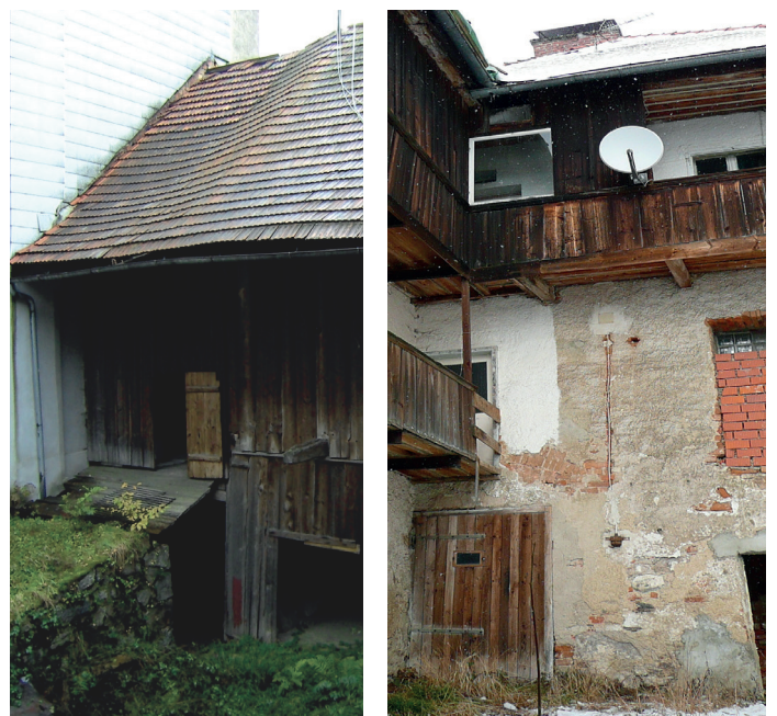
Innenhof „Weiß-Haus“ vor Sanierung in Perlesreut
