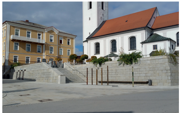
Neugestalteter Kirchenaufgang in Hutthurm
