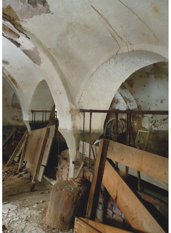
Gewölbekeller „Weiß-Haus“ vor Sanierung in Perlesreut
