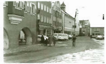
Marktplatz vor der Sanierung
