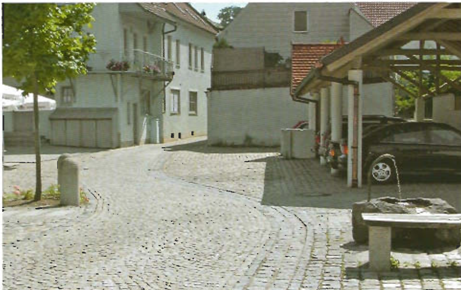
Guggenmoosgasse nach der Sanierung
