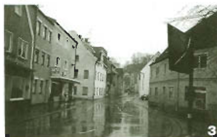
Neugestaltung der Espertstraße mitten im Wohngebiet der nördlichen Altstadt
