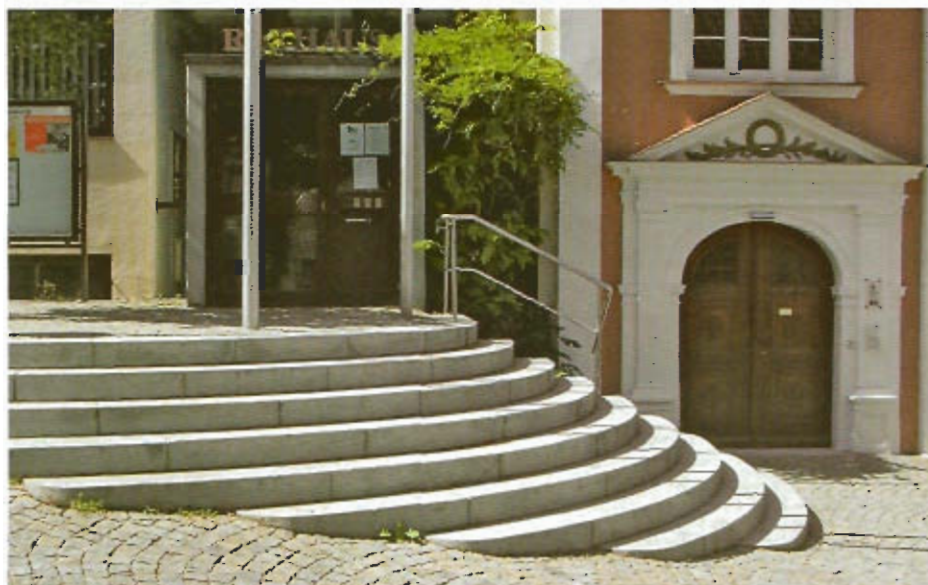
Die neue Rathauseinweitung beim neuen und dem historischen Rathauseingang
