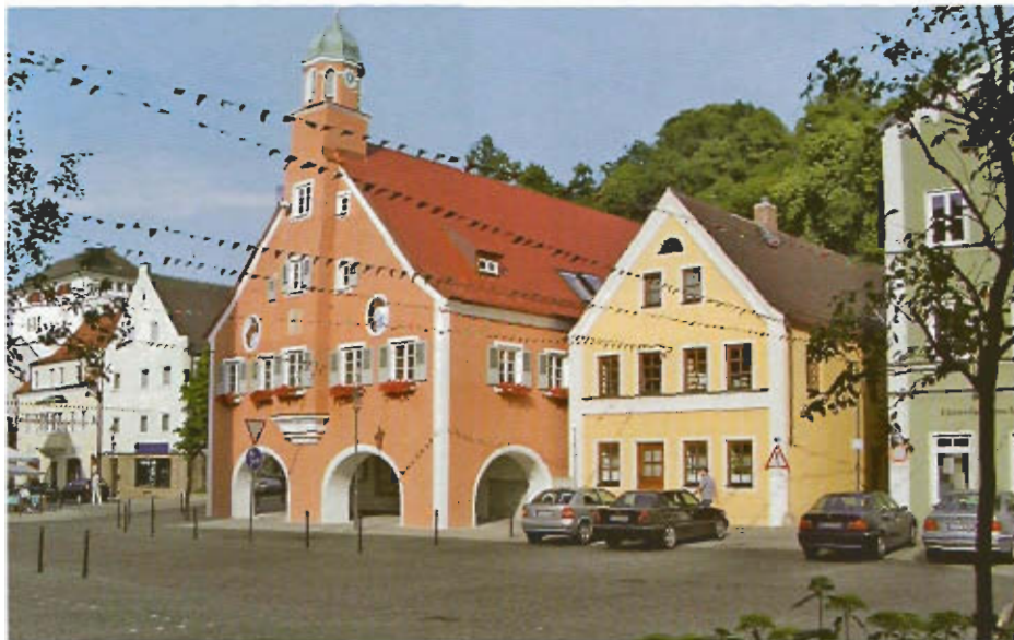
Das sanierte Wurmhaus wurde in die Rathauseinweitung einbezogen
