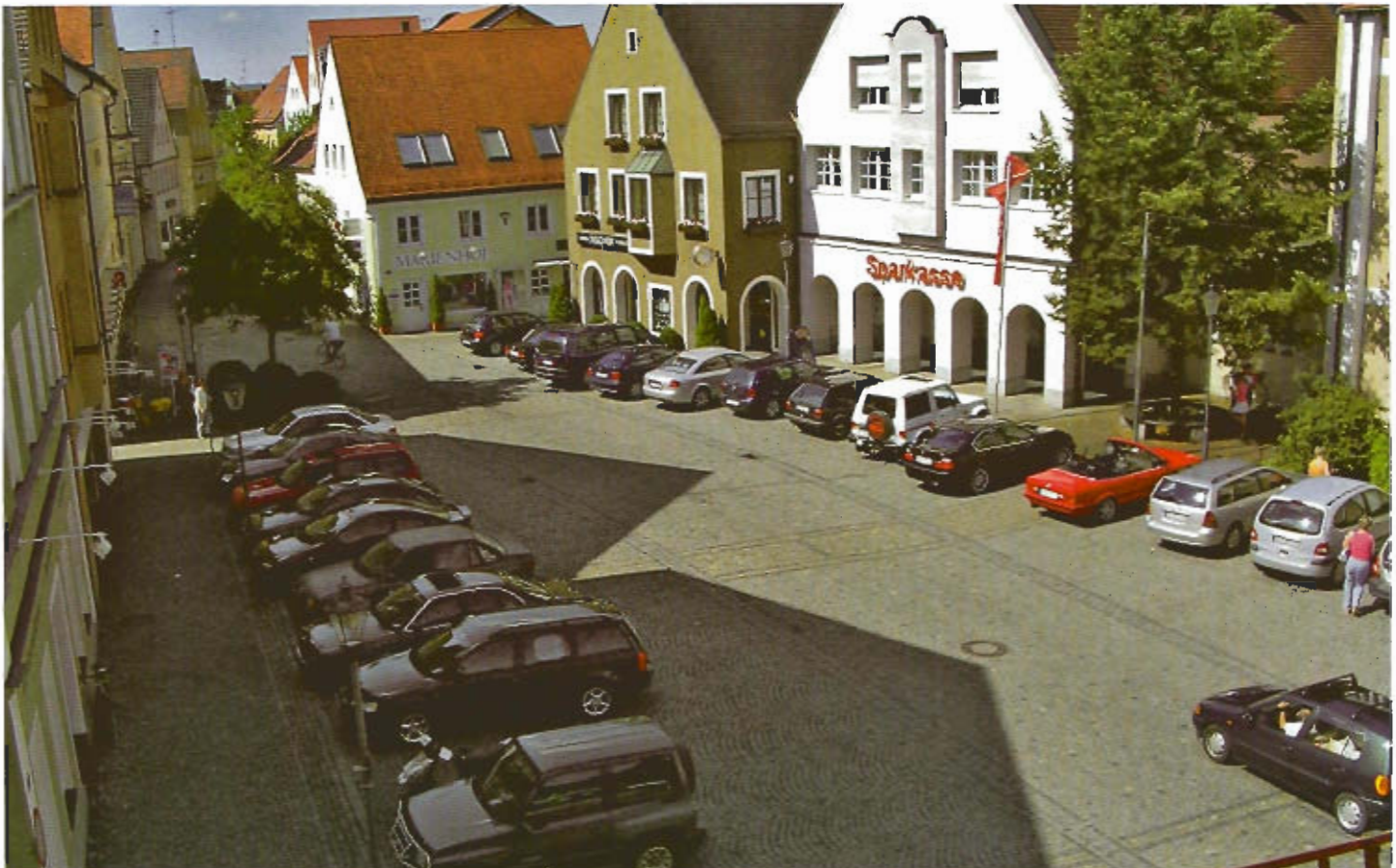
Südlicher Marktplatz nach der Sanierung 2004
