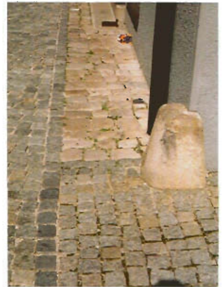
Eckpoller und Kalksteinpflaster
