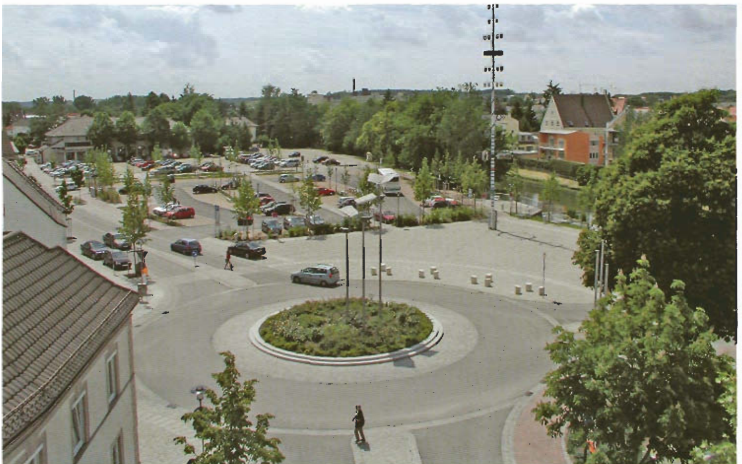
Der neue Kreis im Frühsommer 2004 mit dem ersten Bauabschnitt des Parkplatzes
