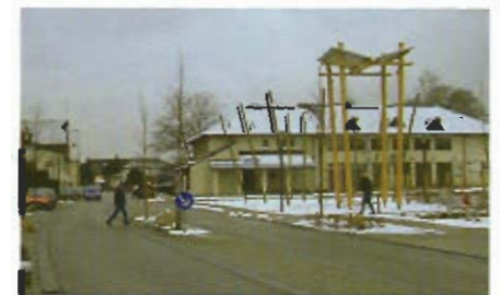
Baustelle Infoturm; Dezember 2004
