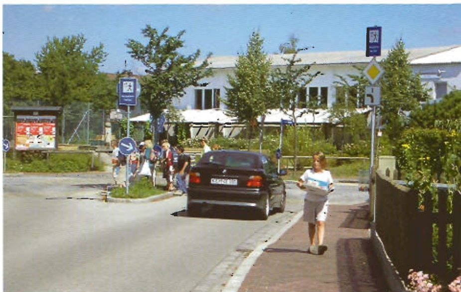
Überquerungshilfe Bogenberger Straße / Am Gabels
