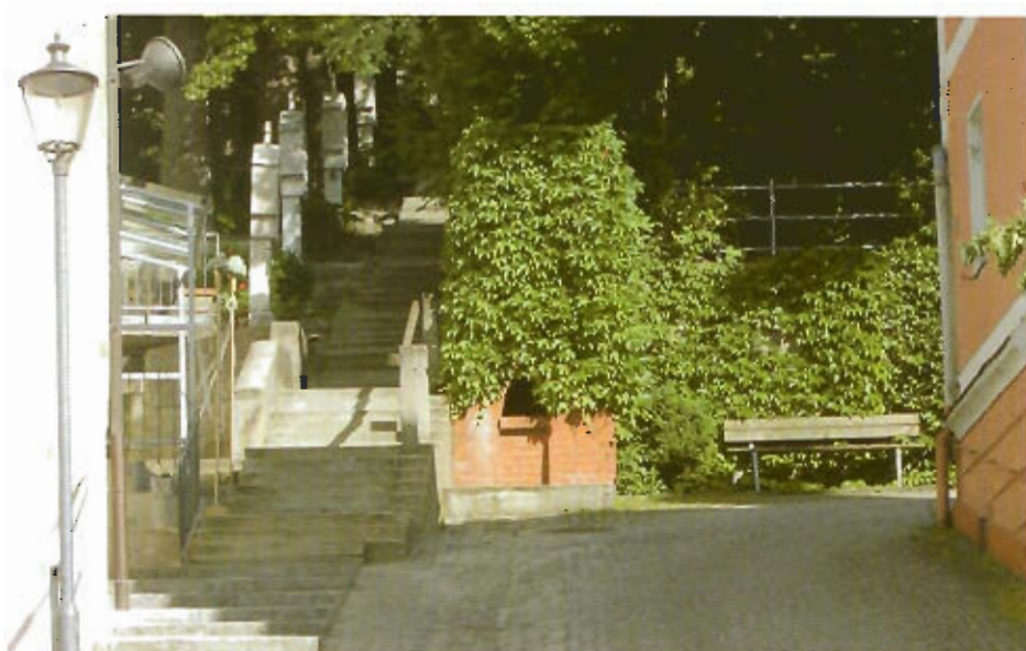
Treppe und Stützmauer am Salvatorberg
