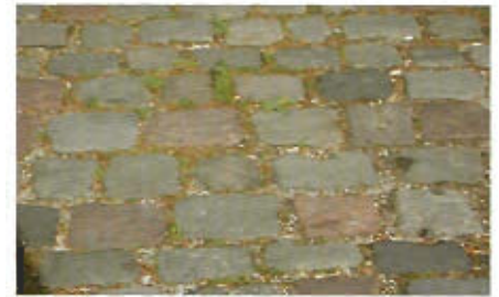
Altes Großsteinpflaster (Knabenschule)
