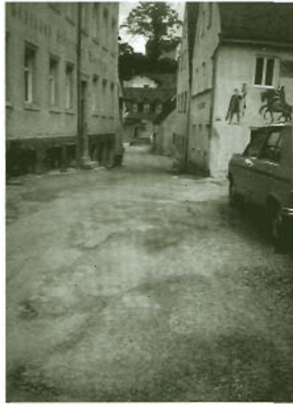
und vor der Sanierung
