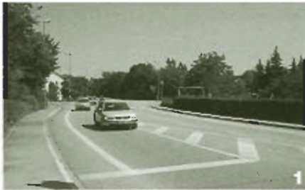
1 Die B 301 durchschneidet nach wie vor störend das Stadtgefüge
