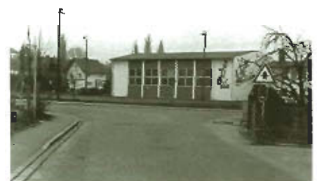
TSV-Sporthalle vor der Sanierung
