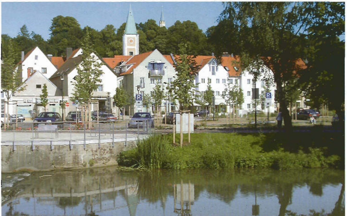
Abensufer, Parkplatz und neuer Altstadttrand an der Paul-Nappenbach-Straße nach der Sanierung
