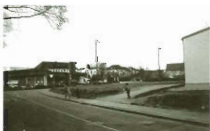
Am Gabis vor der Sanierung
