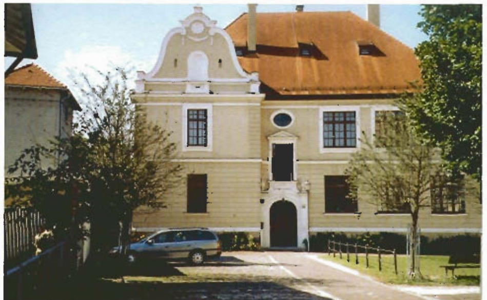
Hof der „Alten Knabenschule“ nach der Sanierung
