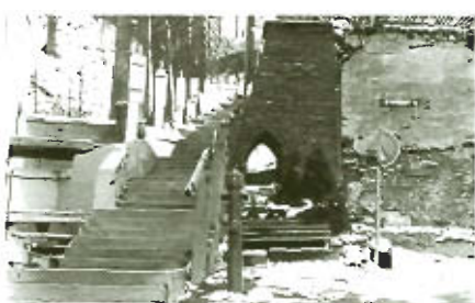
Vor der Sanierung
