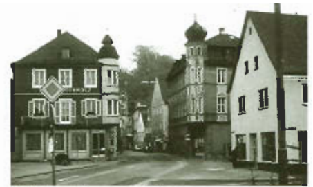
Mittertorstraße vor der Sanierung
