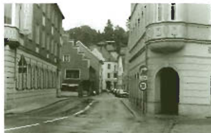
Mittertorstraße vor der Sanierung
